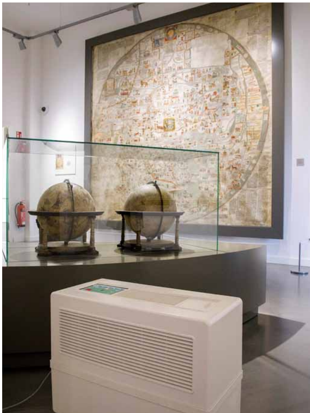
Im Raum, in dem die Ebstorfer Weltkarte hängt, sorgt ein mobiles Gerät für die richtige Luftfeuchtigkeit. Foto: t&w
