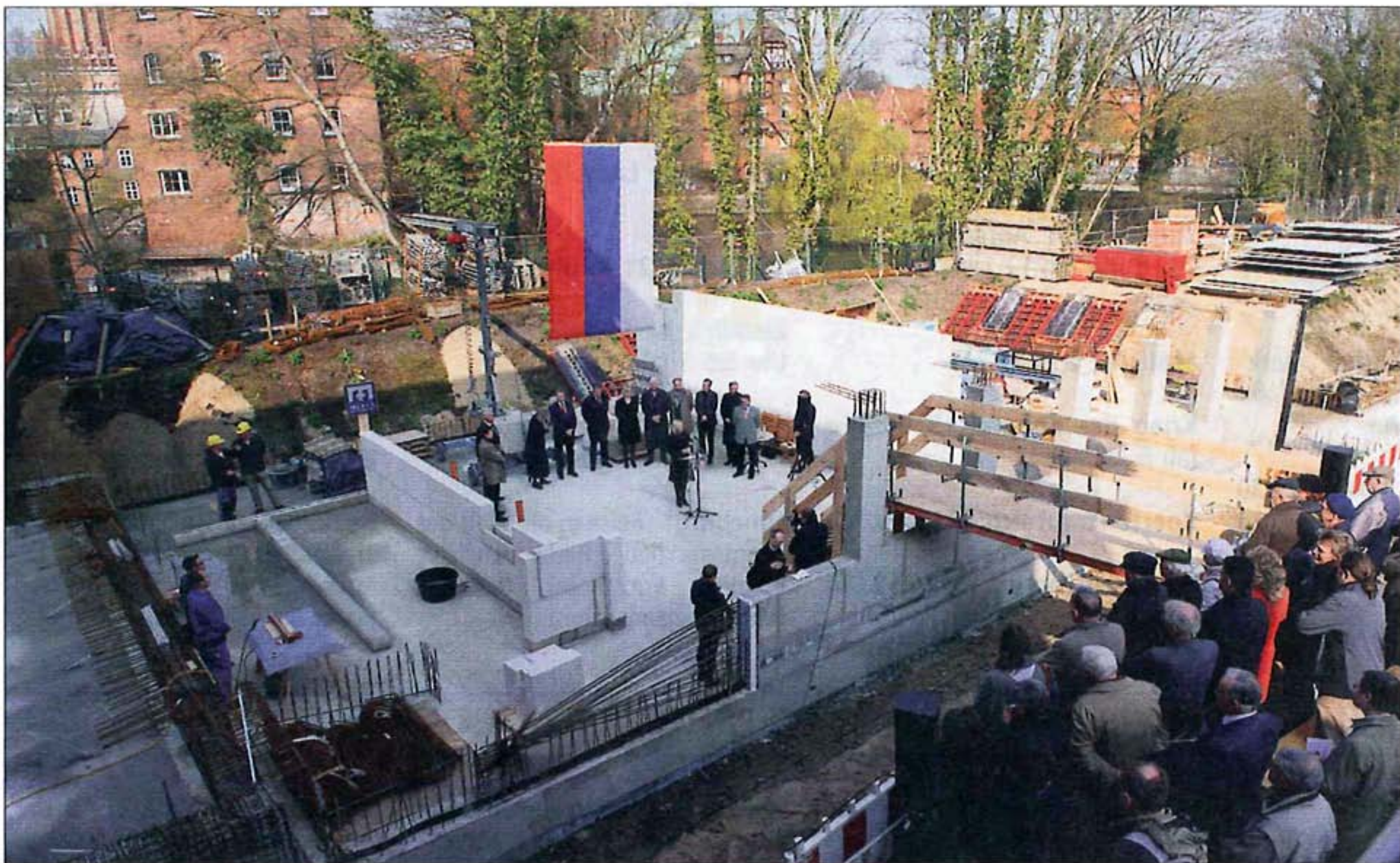
Alles ist zur Grundsteinlegung gerichtet und aufgestellt: Ein Blick während der Zeremonie in die Baugrube des künftigen Museums Lüneburg, dessen Konzept von Ministerin Prof. Dr. Johanna Wanka als innovativ und ungewöhnlich gelobt wird. Foto: t & w
